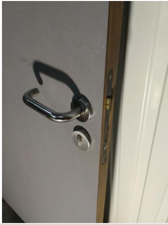
Détail bloc porte
