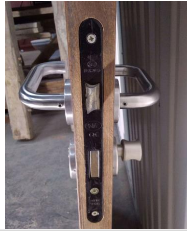
Détail bloc porte
