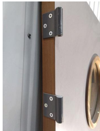
Détail bloc porte
